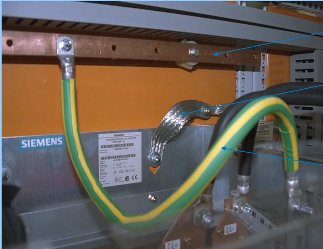
安装固定的接地铜排。
