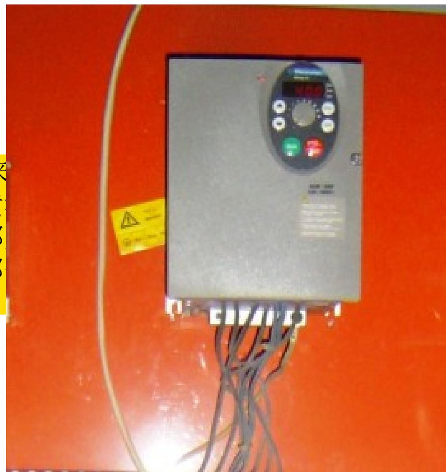
EMC误区- 柜门与柜内底板没有接地连接
